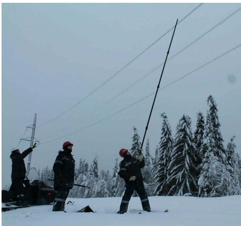
Рисунок 2 – Механическая очистка ЛЭП от льда
